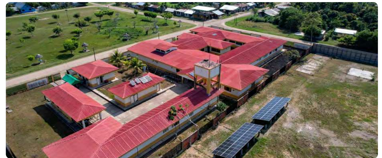
Arriba: Instalación de paneles solares en el Centro de Salud Iparia ubicado en Ucayali. Diego Diaz / Socios En Salud.
